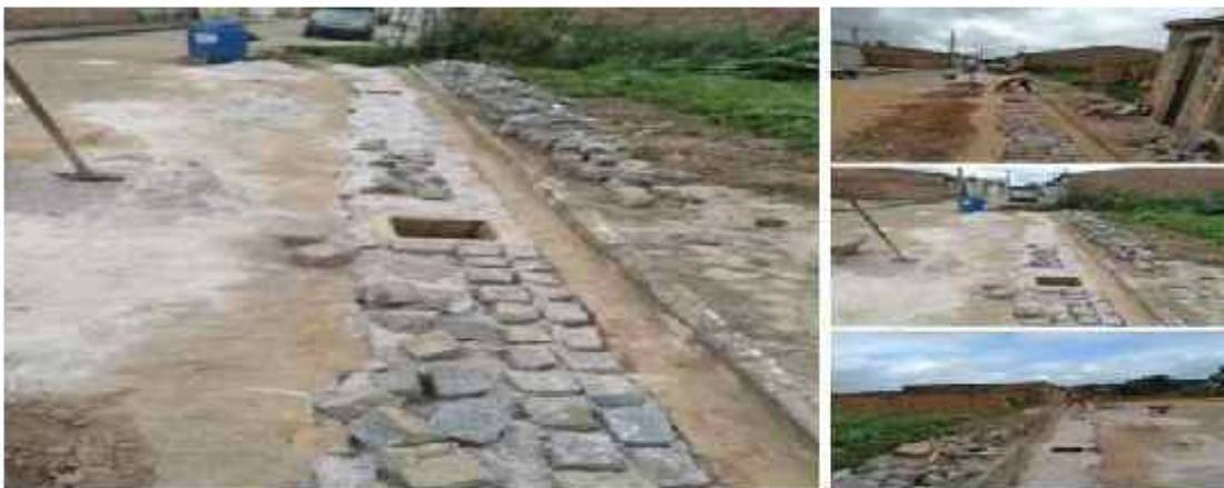
Implantação da rede de drenagem da Travessa 01 Cedro, sede do município
